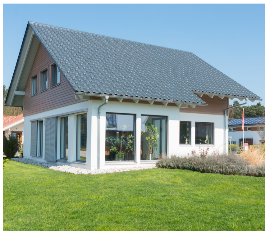
Bei vielen Häusern ist die effizienteste Energiesparmassnahme eine neue Heizung.
