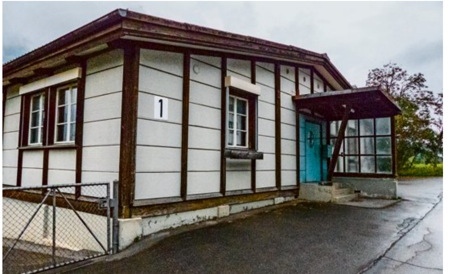
Unterkunft beim Dorfeingang Kandersteg: Dieses Gebäude wird für die Aufnahme von maximal 40 unbegleiteten minderjährigen Asylsuchenden vorbereitet.
