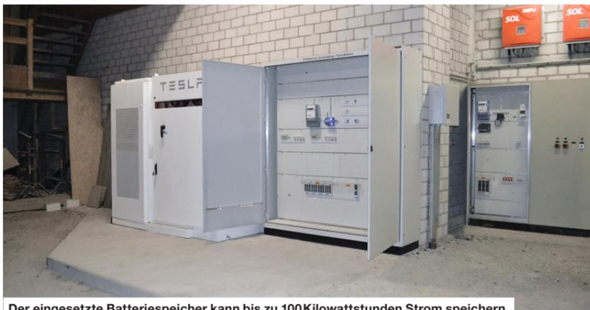
Der eingesetzte Batteriespeicher kann bis zu 100 Kilowattstunden Strom speichern.
