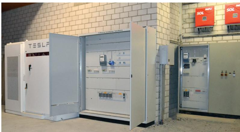
Dieser grosse Batteriespeicher kann bis zu 100 Kilowattstunden Strom speichern.
